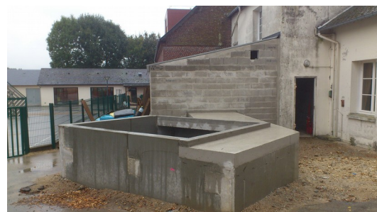
Chantier chaufferie bois déchiqueté 100 kW avec silo enterré.
