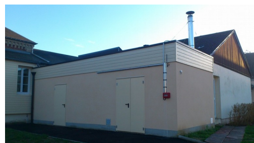
Chaufferie 110 kW granulés.
